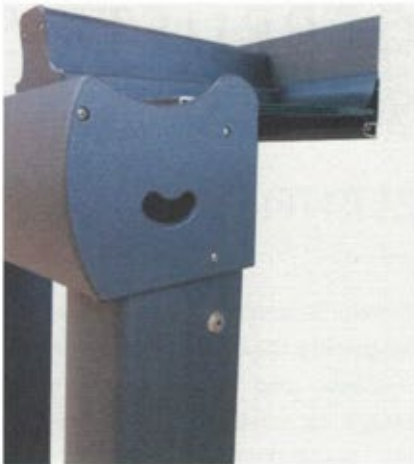
Ansicht Entwässerung mit Fallrohr und Verkleidung
